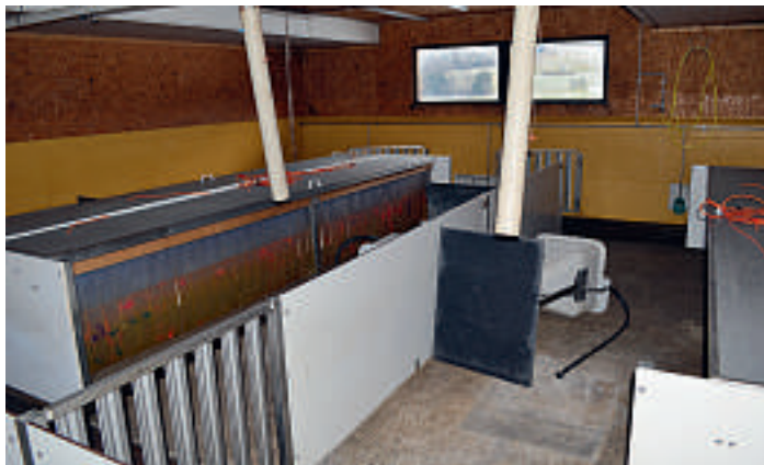
Gereinigter Absetzstall: ursprüngliche Struktur und Farbe sind ersichtlich.
