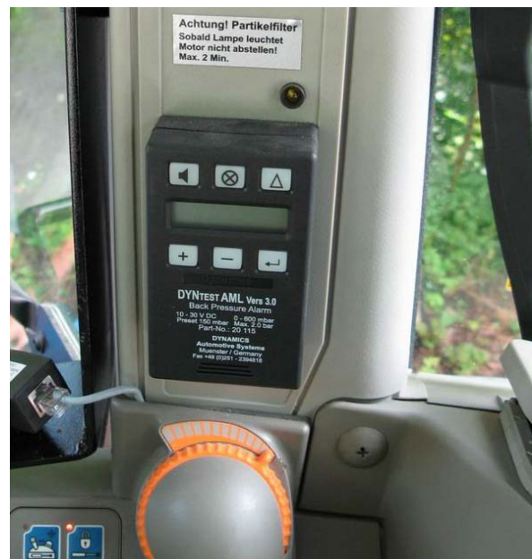
Abbildung 8: Alle Filtersysteme waren mit einer elektronischen Filterüberwachung und Datenspeicherung ausgerüstet.
