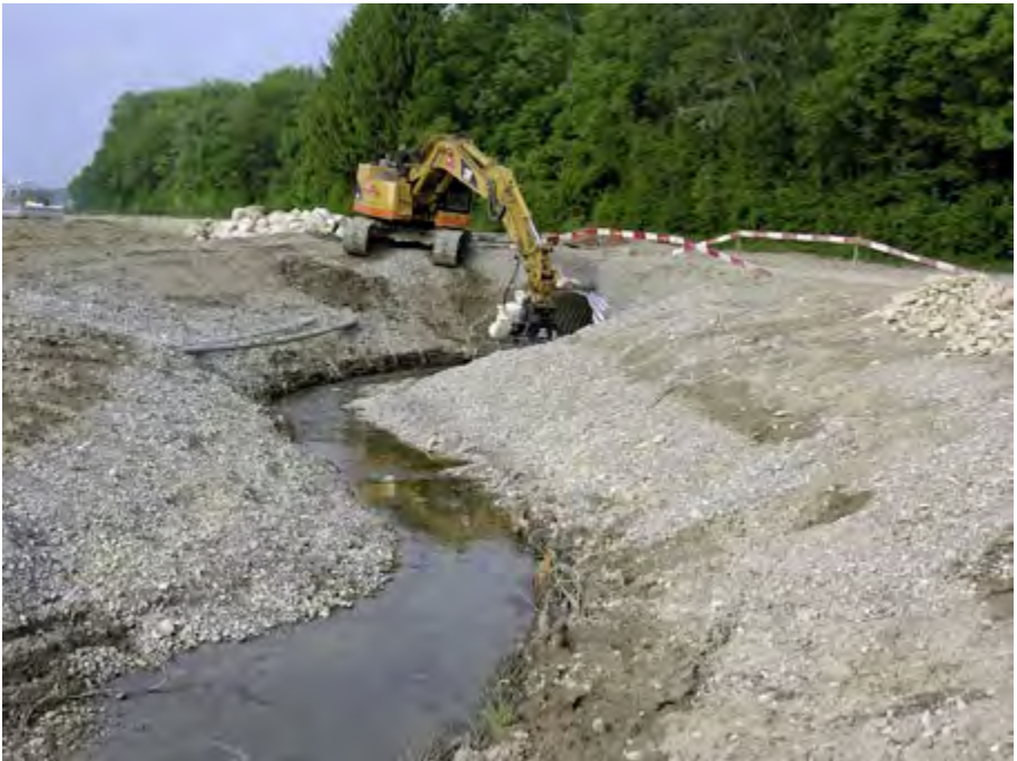
Abbildung 12: Während der Bauphase wirken die Eingriffe häufig massiv.
