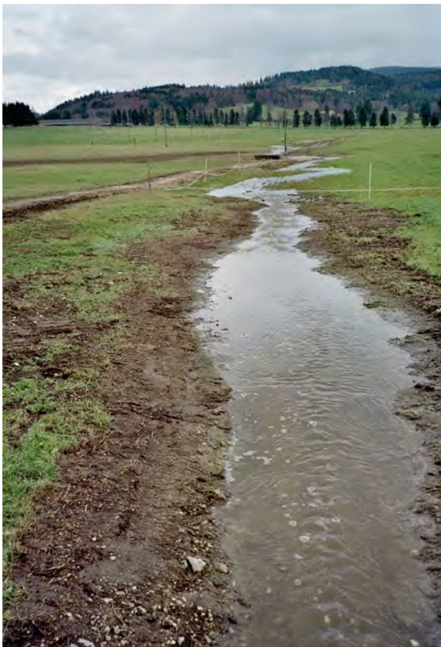
Figure 10: Rouge-Eau dans son nouveau (et ancien!) lit (photo: A. Ducommun, 2009)
