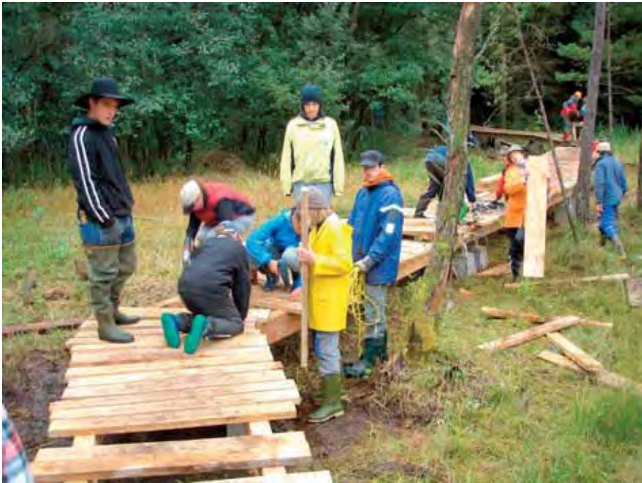
Abbildung 2: Naturschutzgebiet Lörmoos; Erneuern des Holzsteges im Hochmoor durch eine Schulklasse (Arbeitseinsatz «Aktion 72 Stunden»). (Foto: H. Garo, September 2005)
