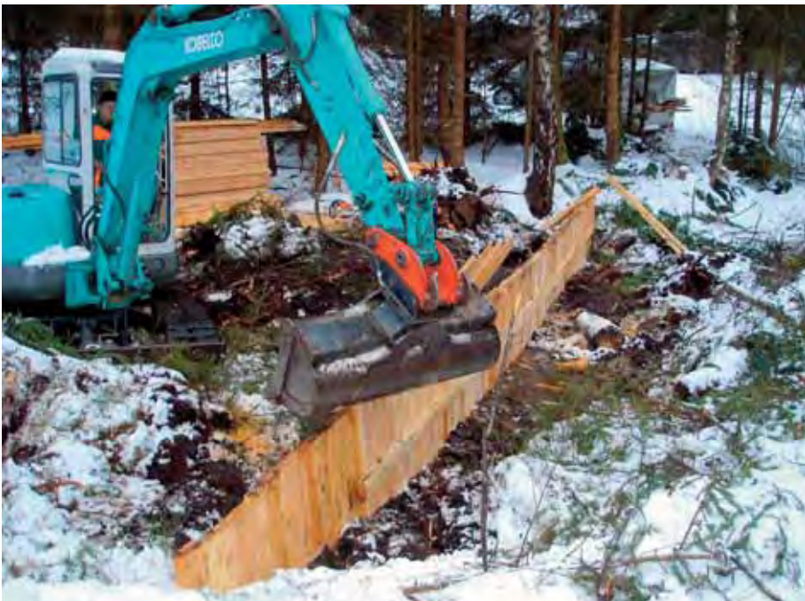
Abbildung 5: Doppelwandiger Sperrenbau Siehenmoos. (Foto: Naturschutzinspektorat, Dezember 2005)
