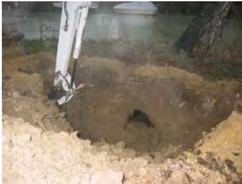
Abb. 6: Vom Biber gegrabene Röhre, die zum Einsturz des Uferwegs am Zihlkanal bei Port (BE) führte.
