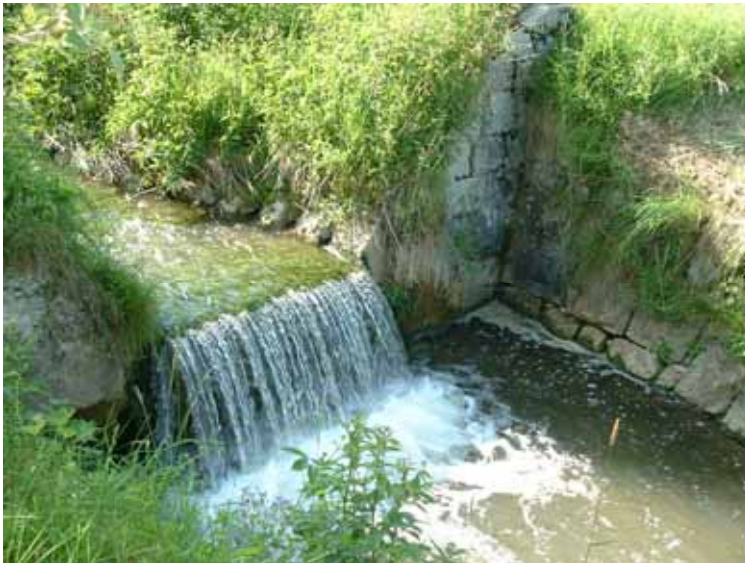
Juin 2002 : chute aval
