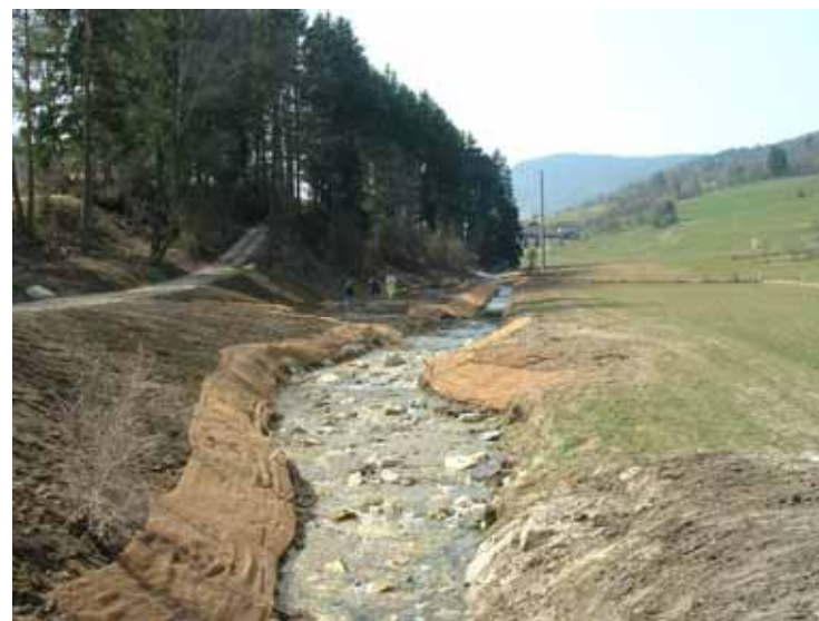
26 mars 2003 : vue depuis le pont, en aval
