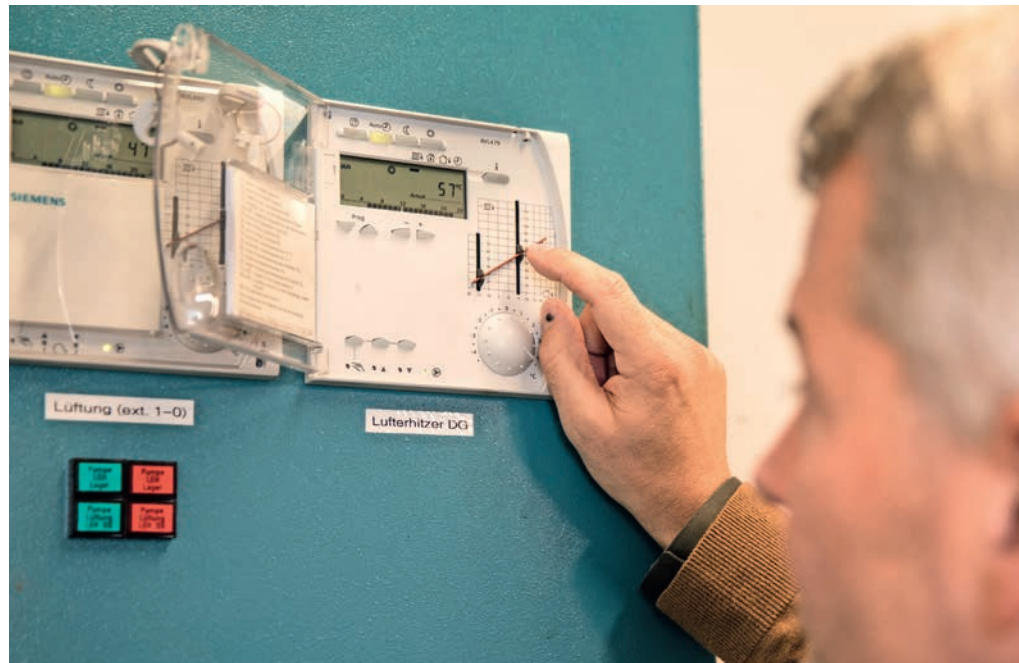
Mit einigen Handgriffen viel gespart: Energiespezialist Mark Wunderlich passt die Heizung an.
